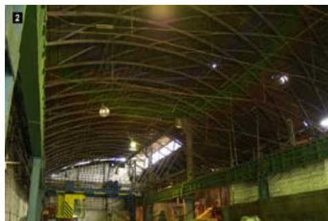
Рис. 2. Перекрытие цеха «Пролет сушки песка»
